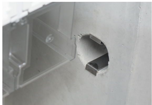
Kabeleinführung links und rechts in der Wand
